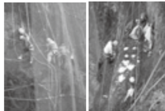
人力作業による除去、 静的破砕剤使用状況 ▶ P. 7
