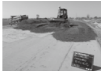
MCブルドーザによる巻出し状況 ▶ P. 5
